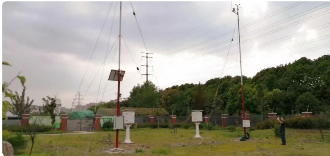
安装青浦实验中学校园气象站设备
